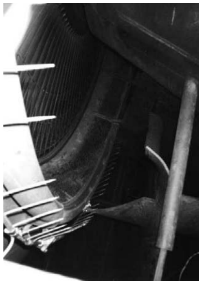
Рис. 2. Общий вид нейтрализатора объемного заряда за последней ступенью турбины Т-250/300-240
