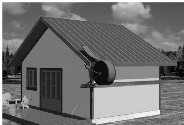
Рис. 5. Монтаж гибких фотоэлектрических модулей
