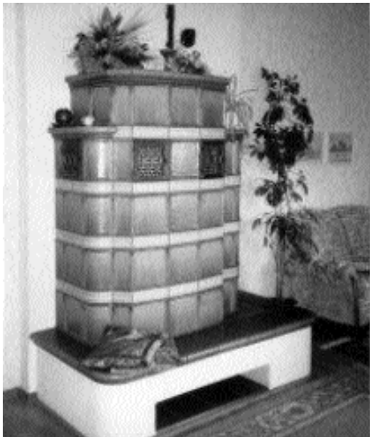
Рис. 2. Типовая электрокафельная печь накопительного типа производства Германии
